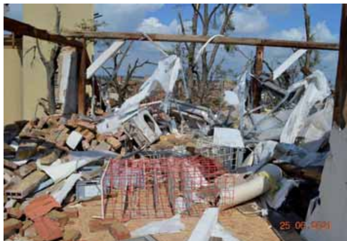
Lékárna dr. Bambase krátce po tornádu.
